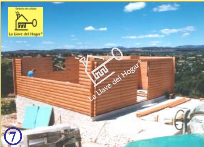
sobre la base del forjado sanitario, nivelada y seca se instala la casa
