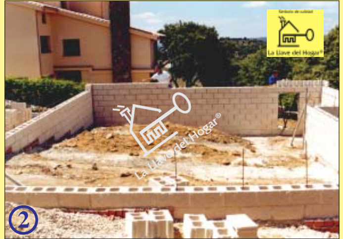
levantado de las paredes de carga con bloques nivelando el forjado
