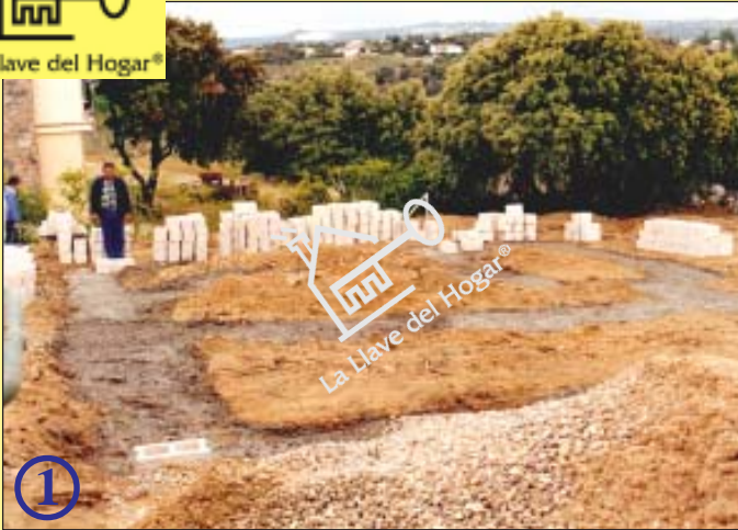
cimiento excavado en la tierra y armado con varillas y hormigón
