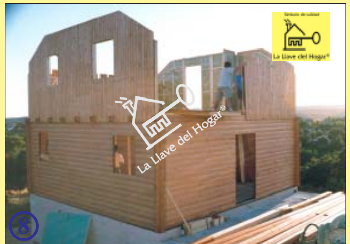
colocada la planta baja de la casa, se instala el resto pieza a pieza
