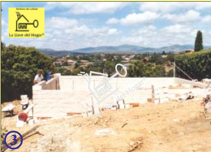
nivelación de la base con bloques rellenos con varillas y hormigón
