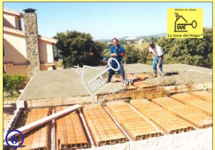
nivelación del planche y calibración del grueso de hormigón H-25
