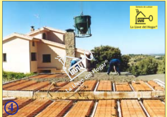
armado forjado de vigas y bobadillas, también el zuncho y mallazo
