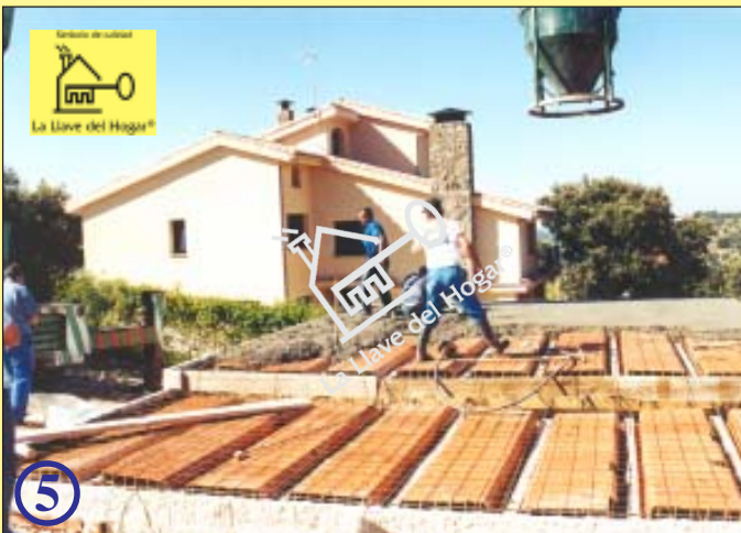
reparto del hormigón sobre el forjado sanitario para nivelar
