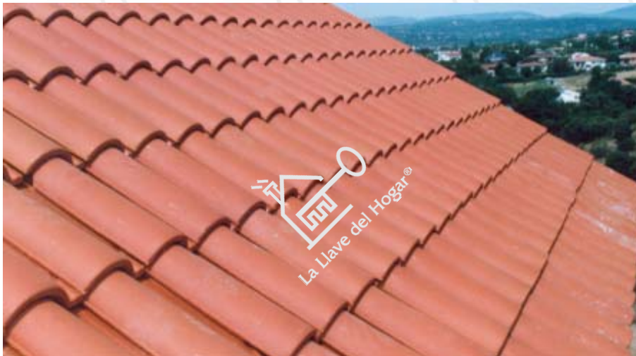
teja mixta sobre rastrel y primera fila con mortero (evitando entrada aves)
