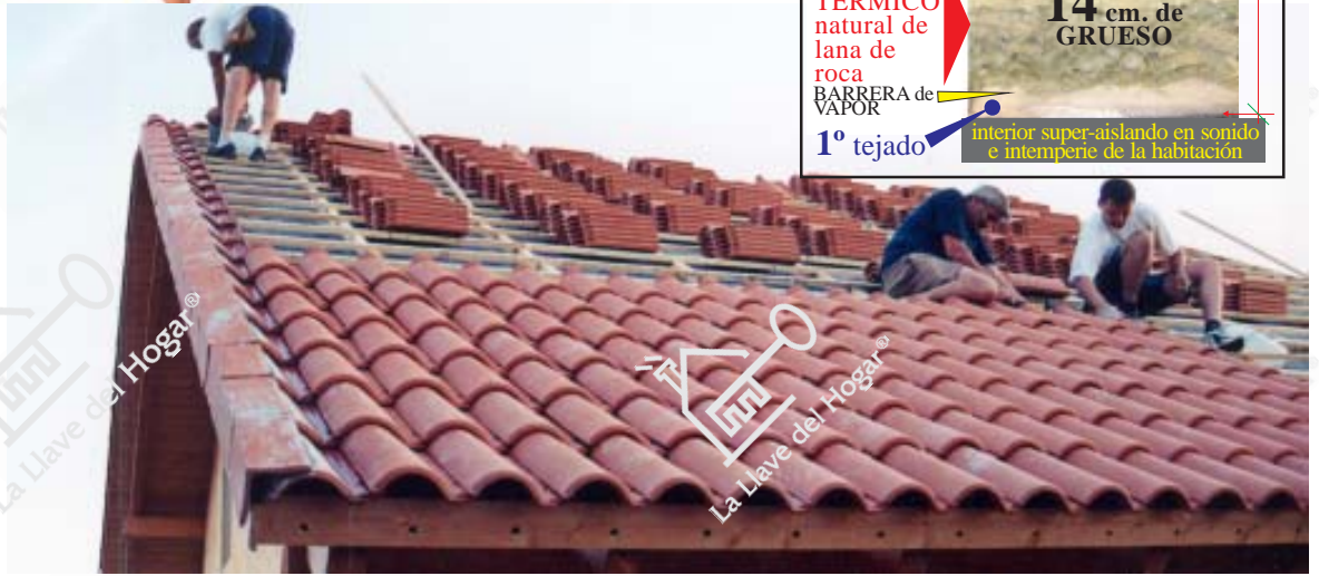
teja mixta sobre rastrel y primera fila con mortero (evitando entrada aves)
